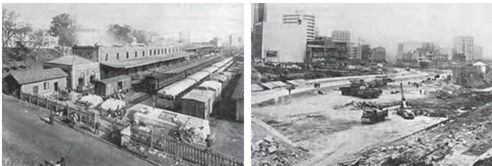
Figuras 64 e 65. O incendio da estación de Norte (1964) e demolición dos restos da estación Fonte: arquivo La Voz de Galicia
