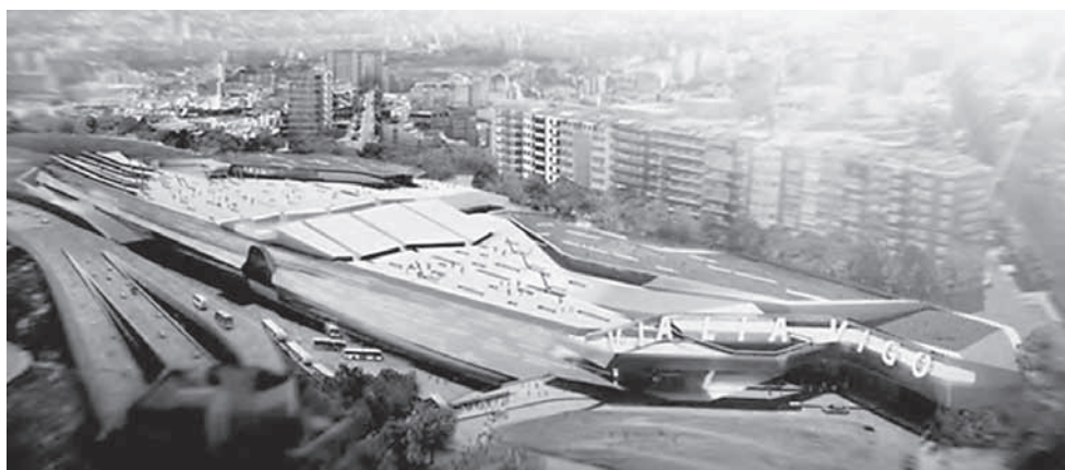
Fig. 76. Vista panorámica da nova estación de Vigo. Fonte: arquivo Faro de Vigo
