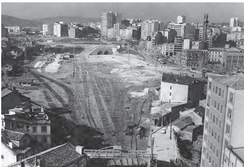
Fig. 66. Desmantelamento de vías da estación de Norte e túneles da avda. Salgado Torres. Fonte: arquivo La Voz de Galicia
