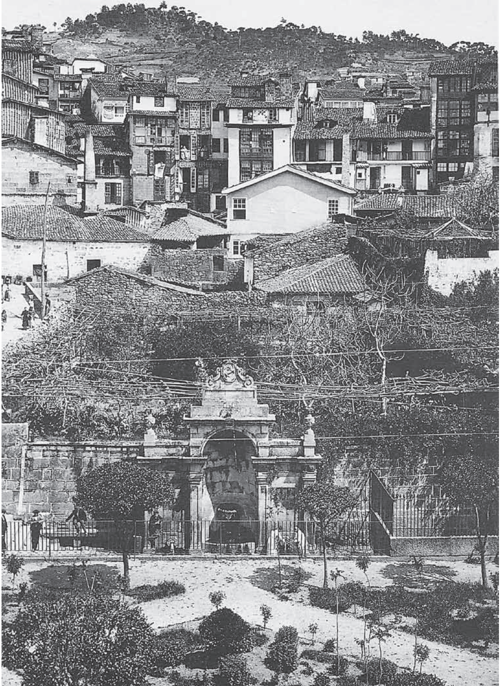
Fotografía general de Las Burgas y de las fachadas de la calle Villar y Cervantes
