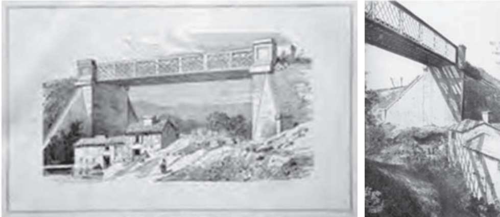
Figuras 13 y 14: Puente sobre el río Sar. Fuente: Ferropedia
