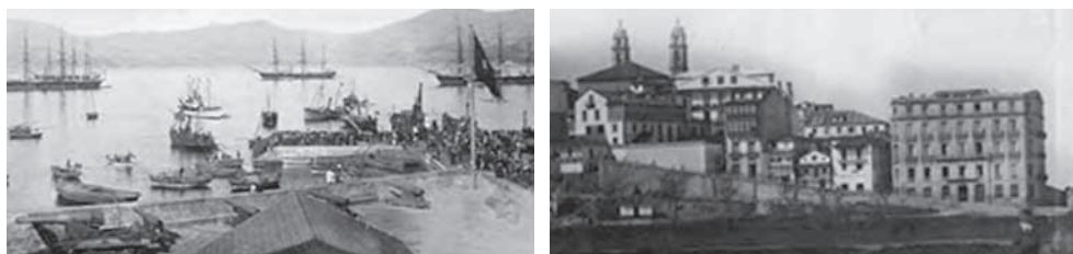
Figuras 32 y 33: Fotografía del muelle de piedra de A Laxe y rellenos para la construcción del ensanche. Fuente, ambas: Foro Vigo (Pontevedra): historia gráfica.
